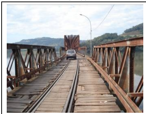
Figura 7 – Trecho Passo Fundo - Marcelino Ramos, Ponte Ferroviária em Marcelino Ramos
