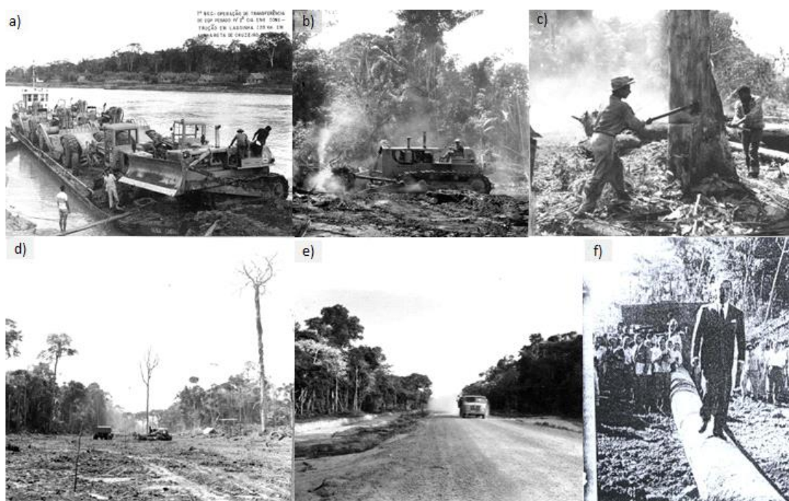
Figura 1 - No mosaico destaca-se a construção da rodovia Brasília-Acre em 1960-1972: a) transporte de máquinas para as frentes de obra em Cruzeiro do Sul, em 1972; b), c) e d) máquinas e homens trabalhando no desmatamento e na terraplanagem; e) trânsito de caminhões pela rodovia; f) presidente Juscelino Kubitschek na solenidade da derrubada da última árvore no trecho de construção, na localidade de Vilhena, em 04 de julho de 1960. Fonte: IBGE, 2017a/b/c/d/e; FERREIRA, 2005.
