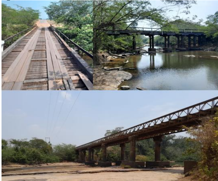
Figura 4. Rodovia BR-432 e as pontes de madeira e metálicas
